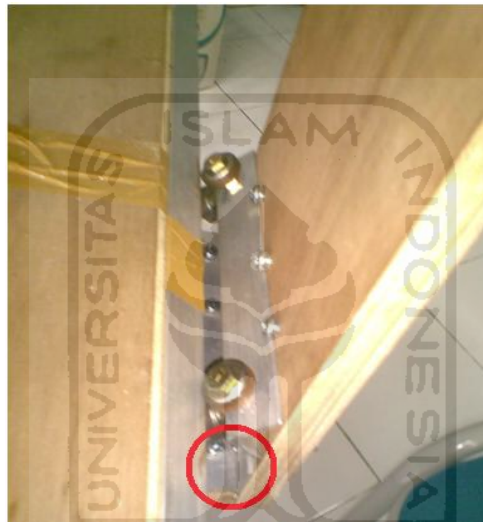
Gambar A.5 Salah satu dari 2 buah sambungan aluminium siku yang menyambung antara gantry dengan penopang gantry
