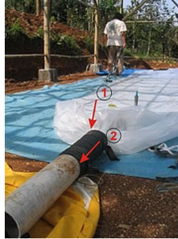
Gambar 2.7. Memasang saluran kotoran
