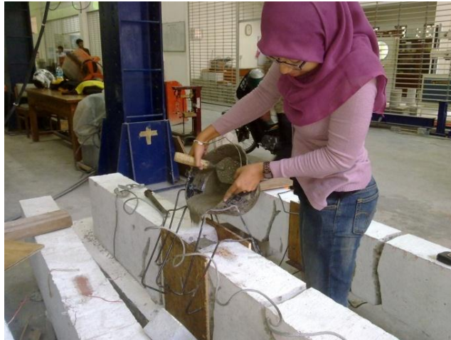
Gambar 4.22 Menuangkan adukan ke dalam celah balok
