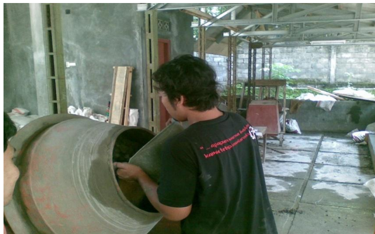
Gambar 7.15 Proses Pencampuran Material
