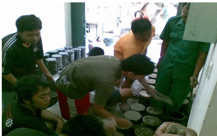
Gambar 7.16 Proses Pencetakan Beton
