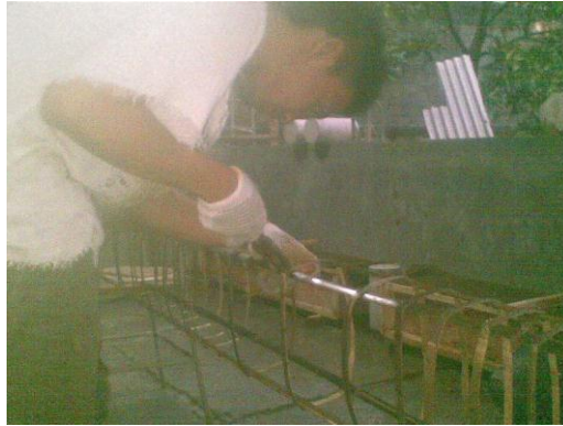
Gambar 4.1 Perangkaian tulangan bambu
