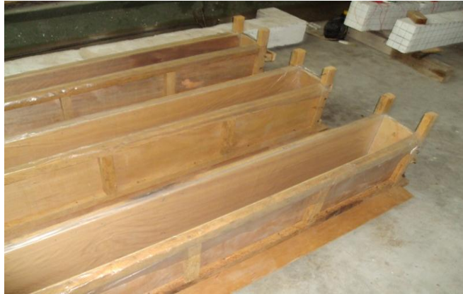
Gambar 4.2 Pembuatan Bekisting
