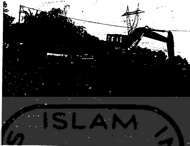
Gambar 3.1. Pekerjaan Galian dengan Excavator
