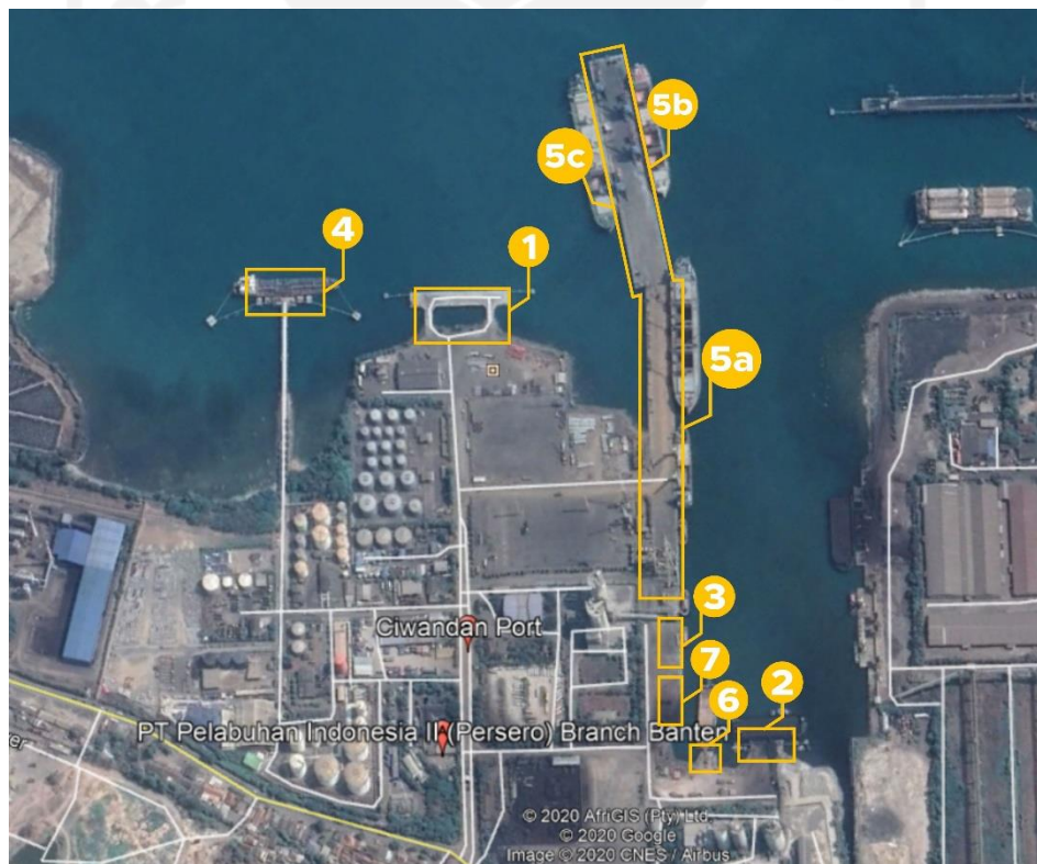
Gambar 1. 2 Lokasi Dermaga-Dermaga di Pelabuhan Ciwandan (Sumber: Google Earth , 2020)
