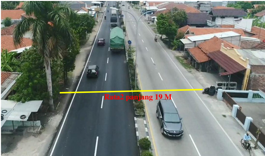
Gambar 5.4 Rumaja STA 169+800 – STA 172+300 yang Tidak Sesuai Standar Yaitu Minimum 24 M
