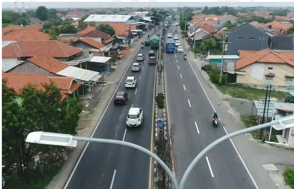
Gambar 5.9 Trotoar pada STA 170+900 yang Tidak Terdapat
