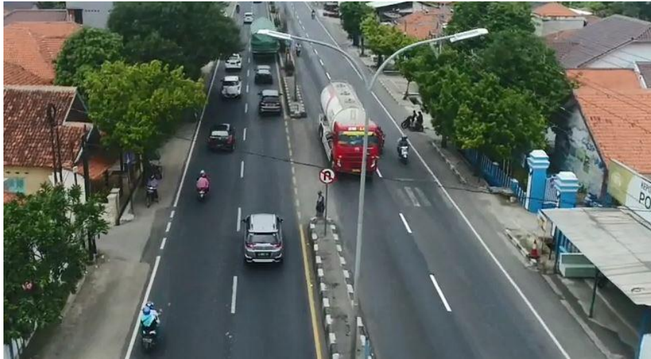
Gambar 5.8 Rel Pengaman pada STA 169+800 – 172+300 yang Tidak Terdapat
