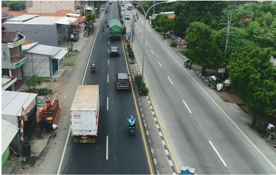
Gambar 5.11 STA 169+800 – 172+300 yang Tidak Terdapat Jembatan Penyebrangan, Penyebrangan Pelican dengan Tombol dan Pagar Pelindung Pejalan Kaki
