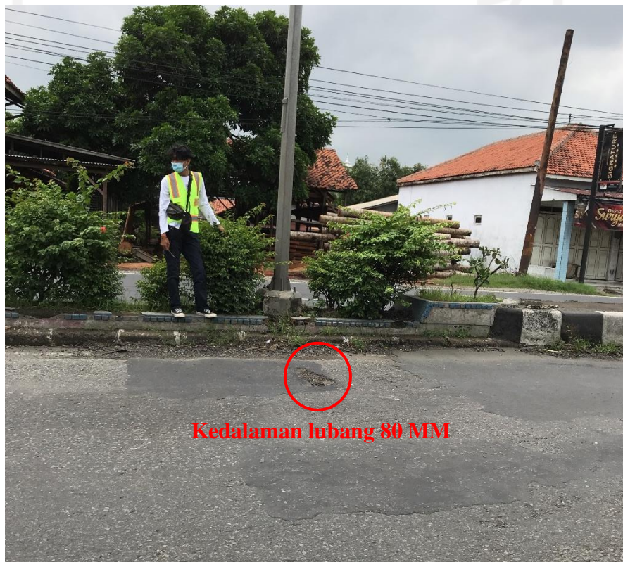
Gambar 5.1 Kondisi Jalan STA 170+600 yang Tidak Sesuai Standar yaitu Maksimum 50 Mm
