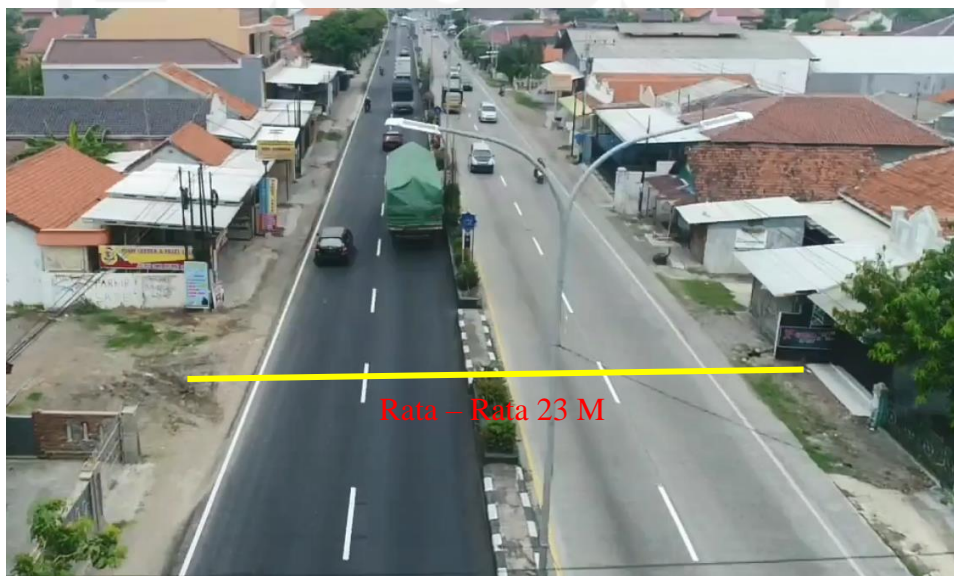
Gambar 5.6 Lebar Rumija pada STA 169+800 – STA 172+200 yang Tidak Sesuai Standar Yaitu Minimum 25 M
