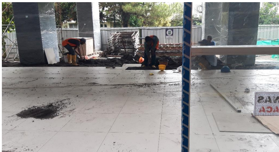
Gambar 5.3 Pekerjaan Keramik Pada Teras
