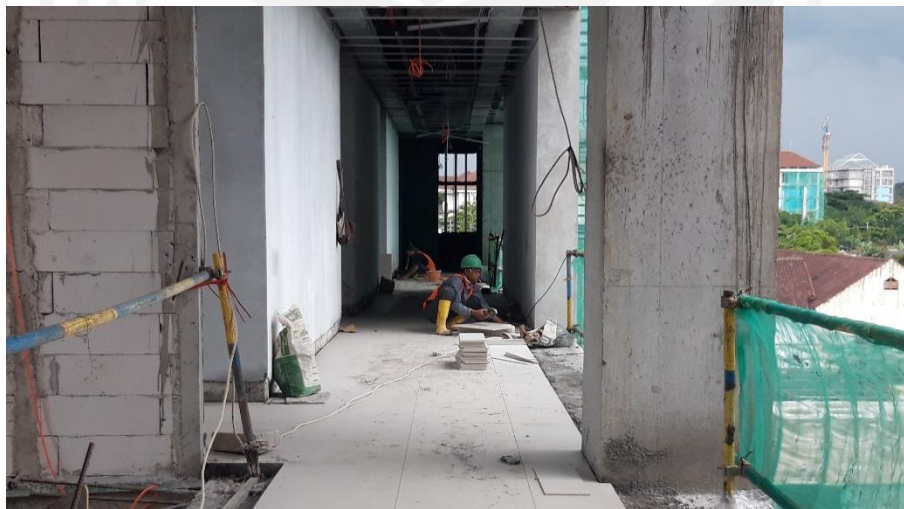
Gambar 5.2 Pekerjaan Keramik Pada Koridor
