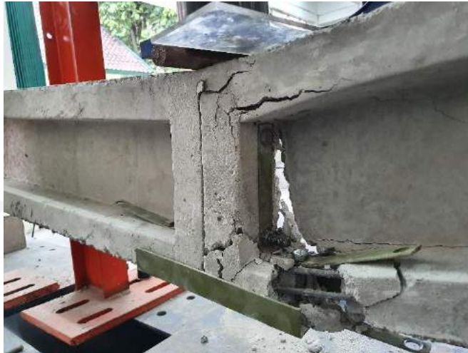
Gambar 5.20 Tampak Belakang Tengah BP-3 Setelah Pengujian
