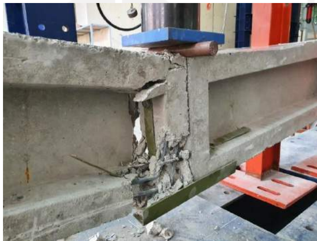
Gambar 5.18 Tampak Belakang Tengah BP-1 Setelah Pengujian
