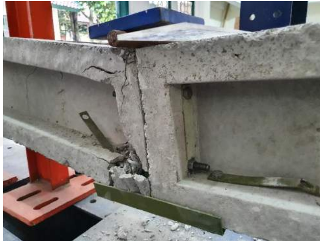
Gambar 5.29 Tampak Belakang BK-3 Tengah Setelah Pengujian
