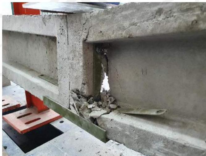
Gambar 5.19 Tampak Belakang Tengah BP-2 Setelah Pengujian
