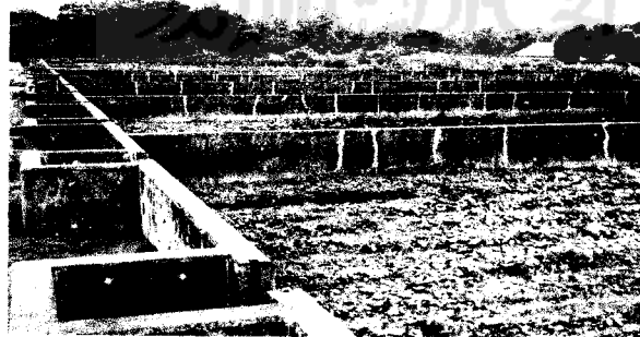
Gambar 3.1. SDB ( Sludge Drying Bed ) Pada Instalasi Pengolahan Air Limbah ( IPAL ) Domestik Sewon Bantul
