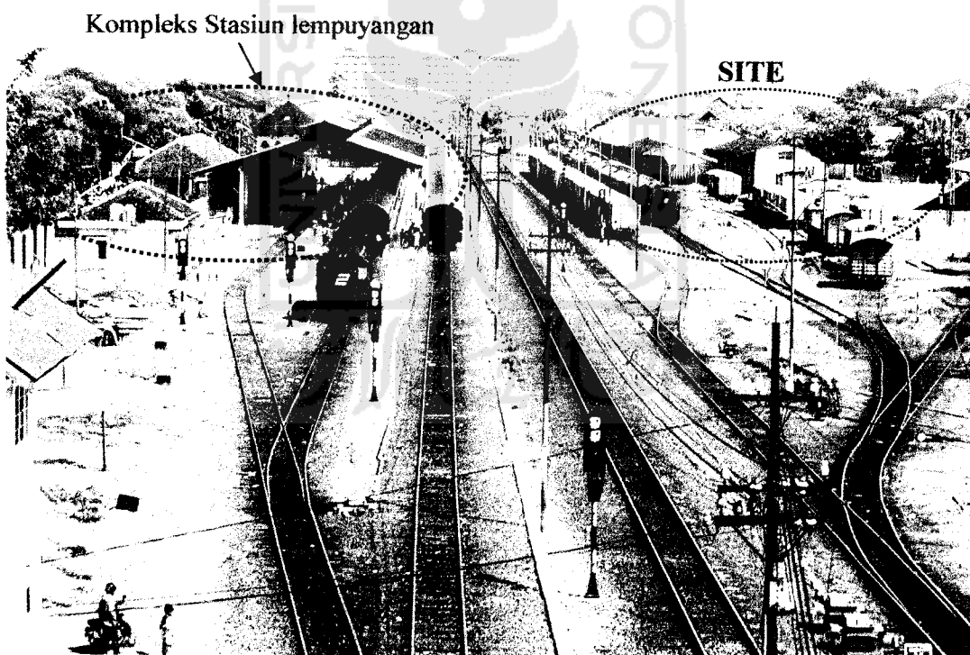
Rencana site museum adalah menggunakan gudang milik indocement, yang berlokasi di sebelah barat laut kompleks Stasiun lempuyangan.
