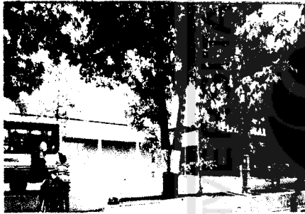
Site dari utara merupakan jalan Jalan utama dan pertokoan
