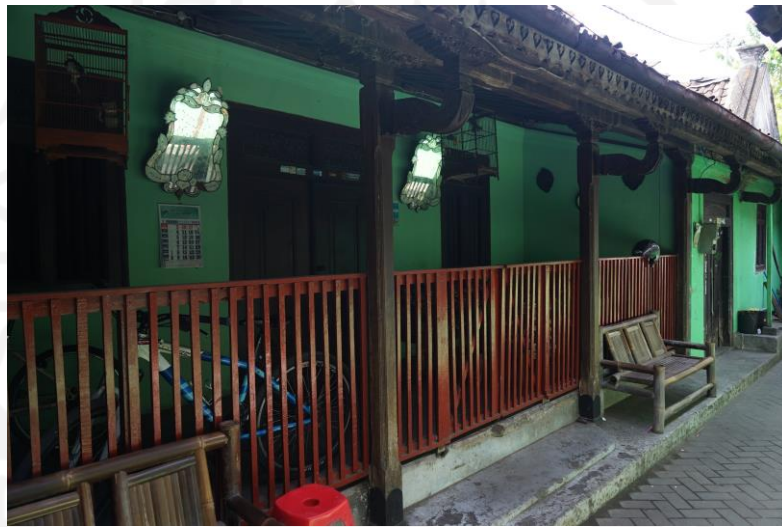
Gambar 35. Peringatan rumah sampel D (Sumber: Observasi, 2021)
