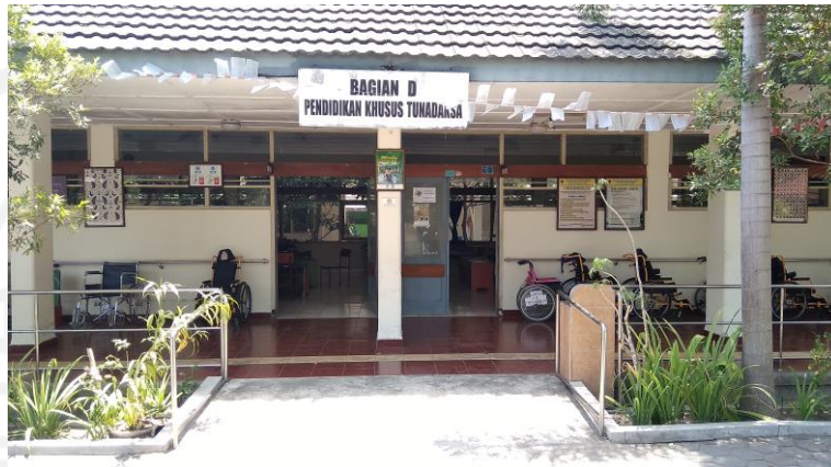
Gambar 19. Bangunan jurusan D SLBN 1 Bantul Sumber: Dokumentasi penulis, 2019
