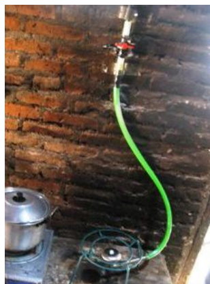
Gambar 2.10 .Kompor Biogas
