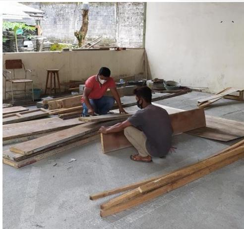
GAMBAR 19 PEMBUATAN BEKISTING BALOK
