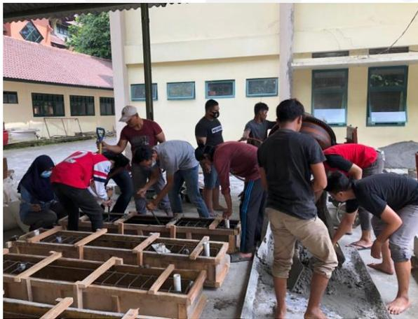
GAMBAR 24 PROSES PENCETAKAN BALOK BETON
