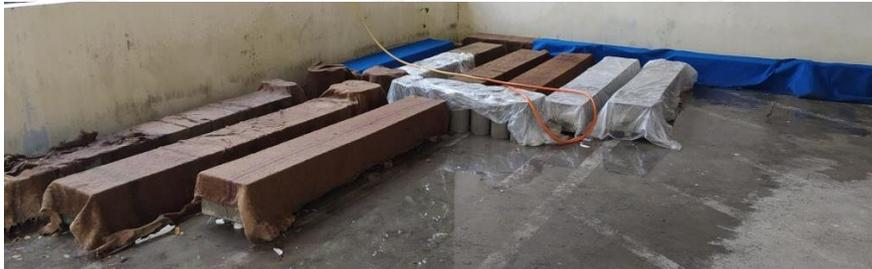
GAMBAR 30 PERAWATAN BALOK BETON DAN SILINDER KONTROL
