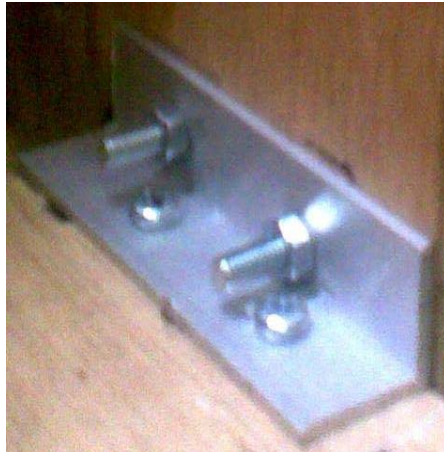
Gambar 2.40 Sambungan kombinasi siku aluminium dan mur-baut
