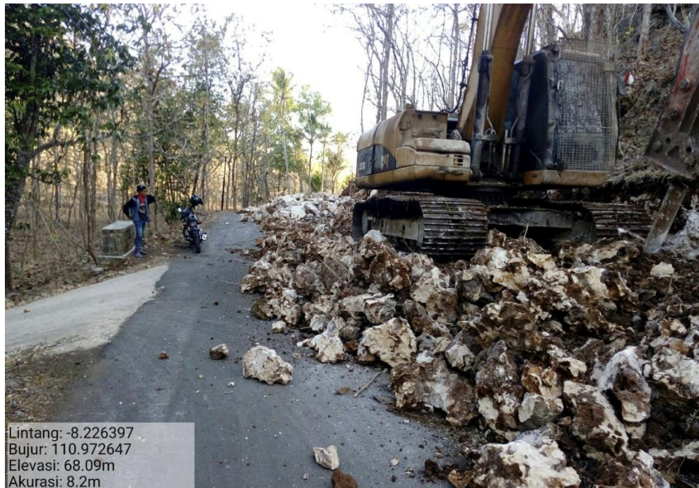
Gambar 3 Proyek Rehabilitas Peningkatan Jalan Dadapan
