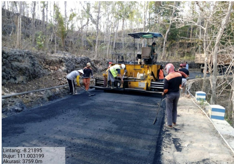
Gambar 5 Proyek Rehabilitas Peningkatan Jalan Dadapan
