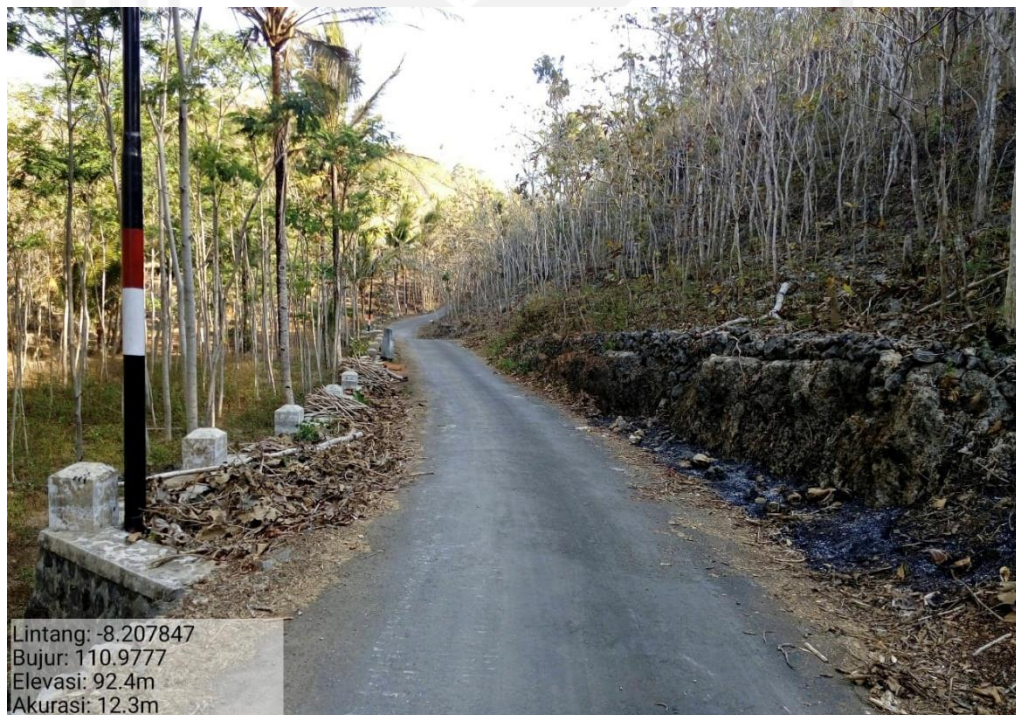
Gambar 4 Proyek Rehabilitas Peningkatan Jalan Dadapan
