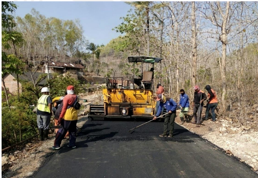
Gambar 10 Proyek Rehabilitas Peningkatan Jalan Dadapan
