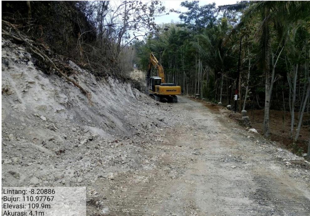
Gambar 6 Proyek Rehabilitas Peningkatan Jalan Dadapan
