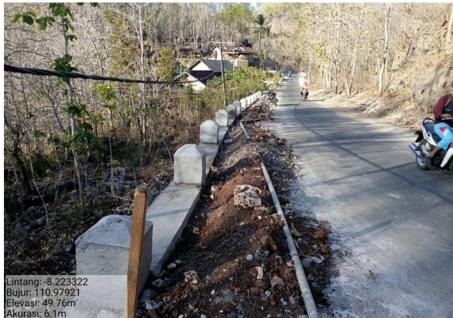
Gambar 1 Proyek Rehabilitas Peningkatan Jalan Dadapan
