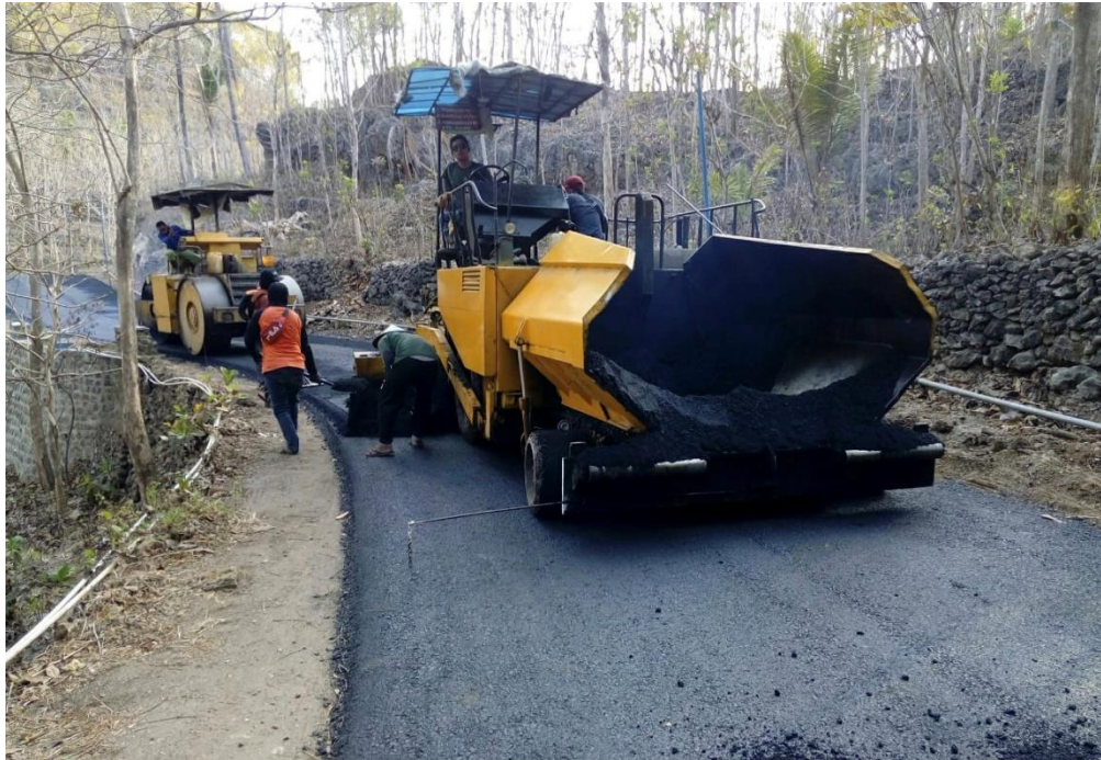
Gambar 9 Proyek Rehabilitas Peningkatan Jalan Dadapan
