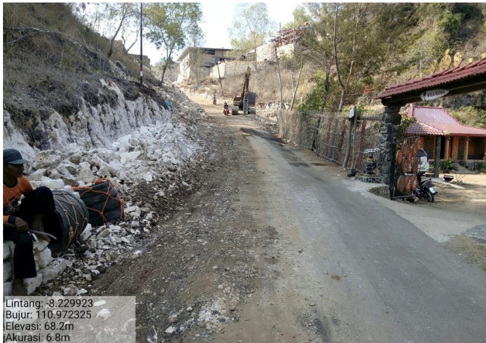
Gambar 7 Proyek Rehabilitas Peningkatan Jalan Dadapan
