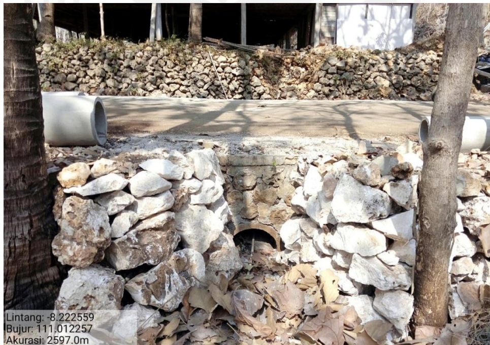
Gambar 8 Proyek Rehabilitas Peningkatan Jalan Dadapan
