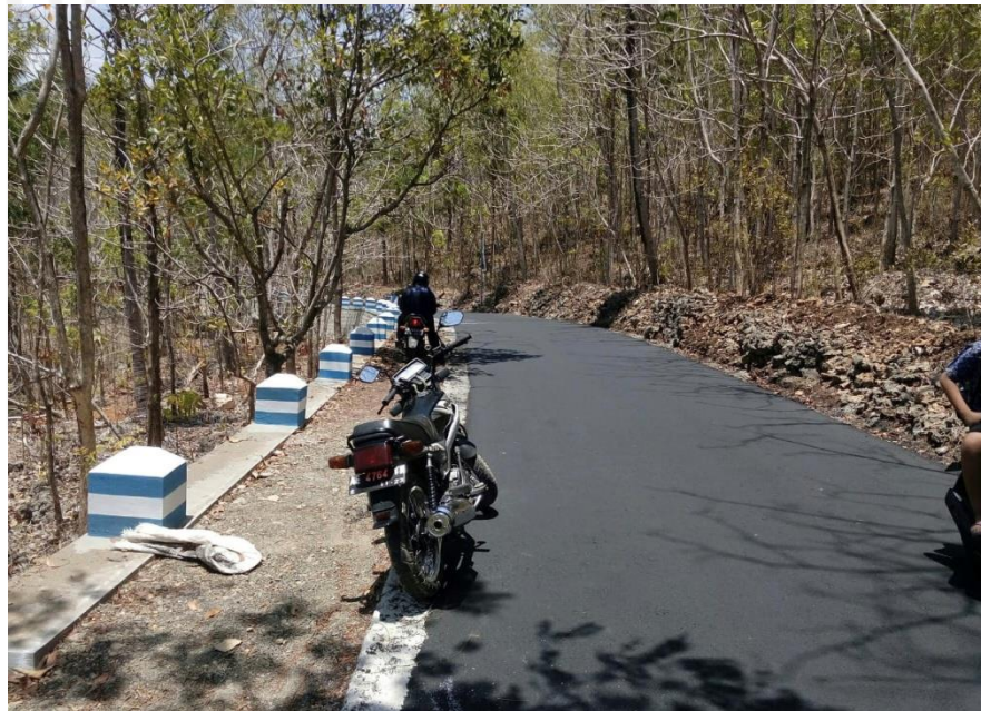
Gambar 2 Proyek Rehabilitas Peningkatan Jalan Dadapan
