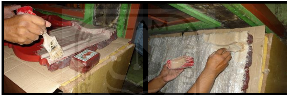
Gambar 4.3. Pelapisan serat gelas
