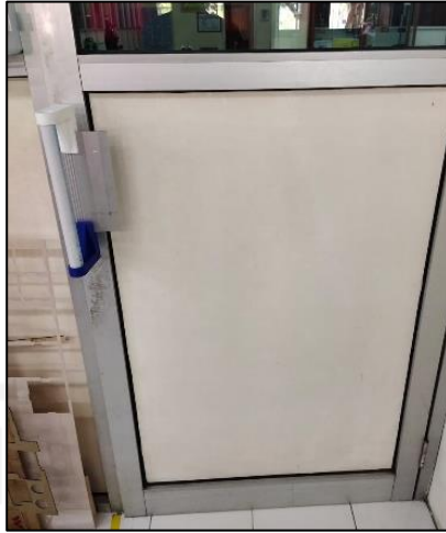
Gambar 3-66 Pemasangan Gagang Pintu Tambahan
