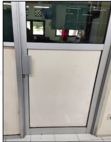
Gambar 3-64 Pintu Laboratorium Mekanika
