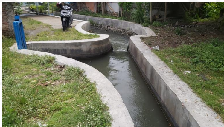
Gambar 4. 8 Kondisi Lapangan (sumber: Survei, 4 Desember 2020)
