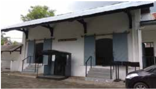
6. Bangunan Heritage Ruang Tiket dan Adminitrasi.
