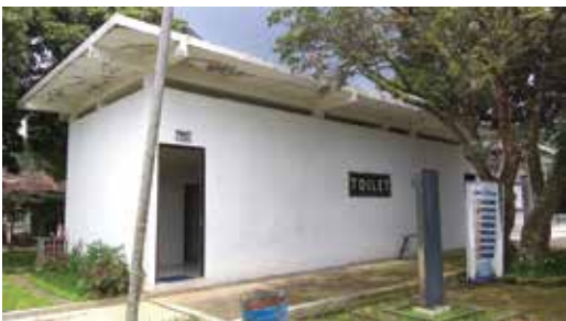
8 & 9. Toilet wisata dan Musholla Museum Stasiun KA Ambarawa.
