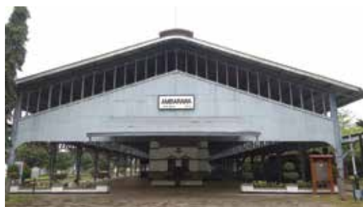
10. Peron dan Bangunan Heritage Stasiun Museum KA Ambarawa
