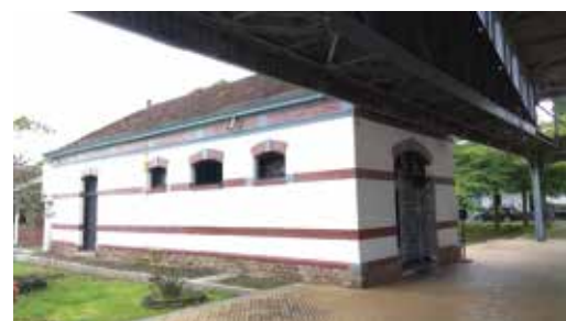
11. Bangunan Heritage Gudang Mesin Museum Stasiun KA Ambarawa.
