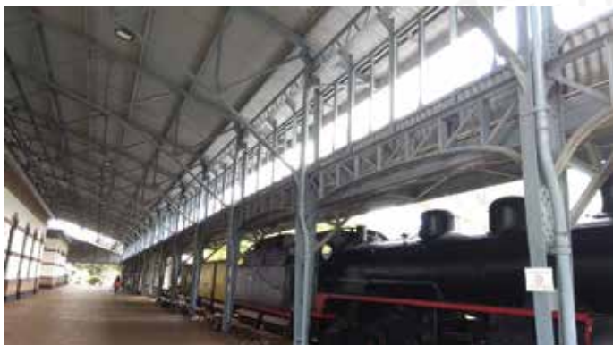
Gambar 47 : Detail Struktur Stasiun KA Ambarawa Sumber : Penulis, 2021
