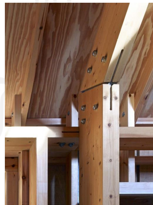
Gambar 39. Sambungan Plat Baja Dengan Kayu 2
