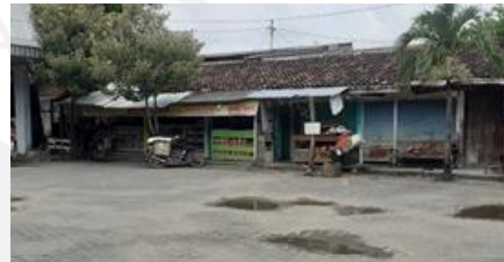
Gambar 3. Kondisi Bekas Kios
