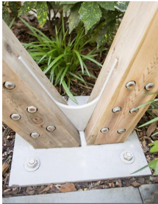
Gambar 40. Sambungan Plat Baja Dengan Kayu 3
