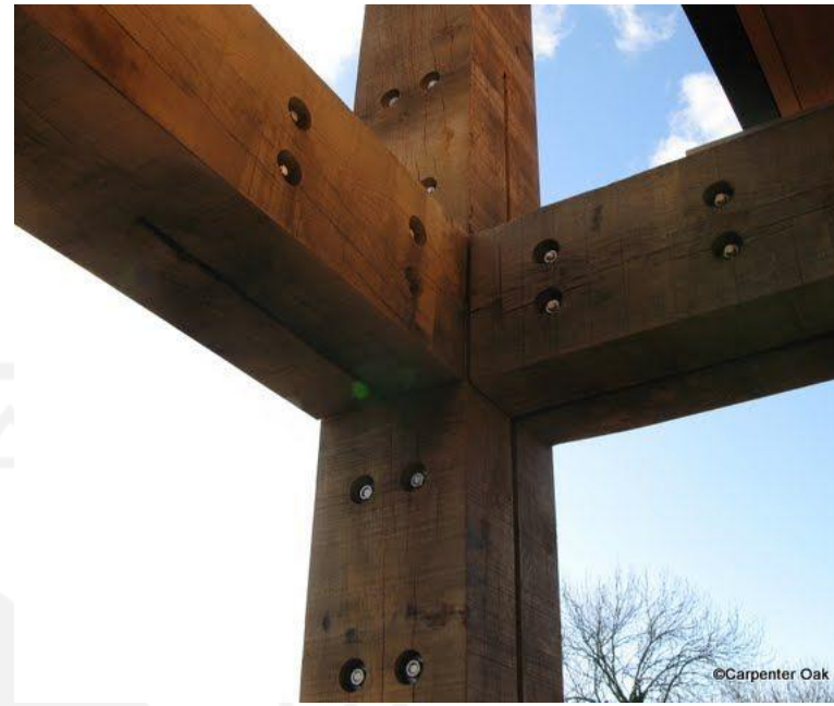
Gambar 41. Sambungan Plat Baja Dengan Kayu 4
