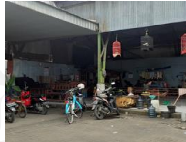
Gambar 4. Kondisi dalam bekas Stasiun Kota Purwodadi
