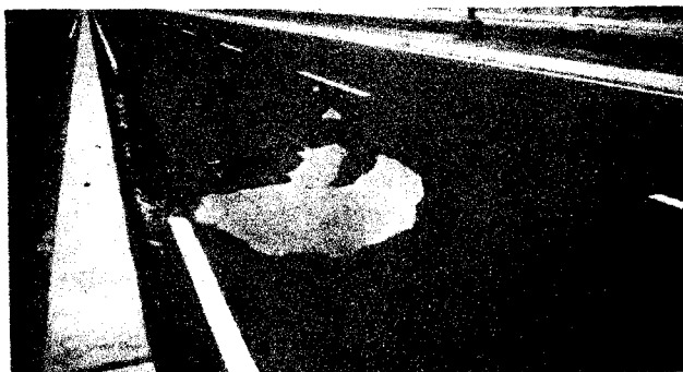
Gambar 4.4 Jenis Kerusakan Pengelupasan Lapisan Permukaan ( Stripping )
