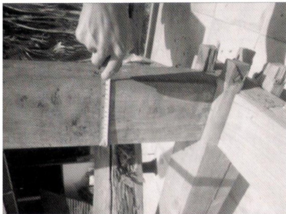
Sambungan pojok saka guru dengan sunduk pamanjang dan sunduk panyelak
