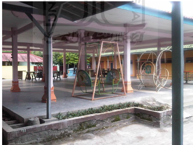
Gambar 4.5 Joglo di tengah kompleks bangunan YPAC Surakarta yang tak berfungsi dengan baik dan hanya digunakan sebagai tempat meletakkan permainan anak-anak.
