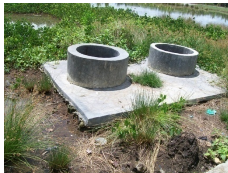
Gambar 4.29. Sumur air bersih Sumber : Surve 2011
