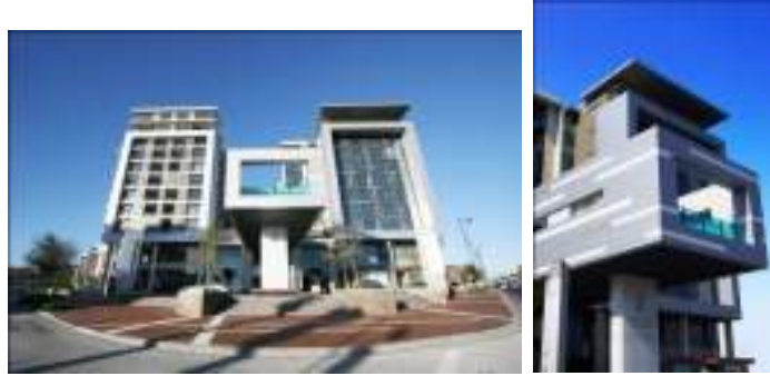
Gambar 2.55 Bentuk bangunan Sumber : www.google.com
