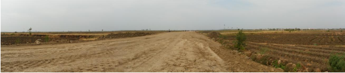
Gambar 2.6. Kondisi Pembangunan Jalan Lingkar
