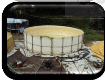
**Tahap 2 :** pada penampungan baner ini air di campur menggunakan tawas untuk proses penjernihan selama kurang lebih 15 menit. Setelah itu masuk ke tahap 3. (gambar 3.3 : *fastek*. Sumber : survey PMI tanggal 31 januari 2011)
