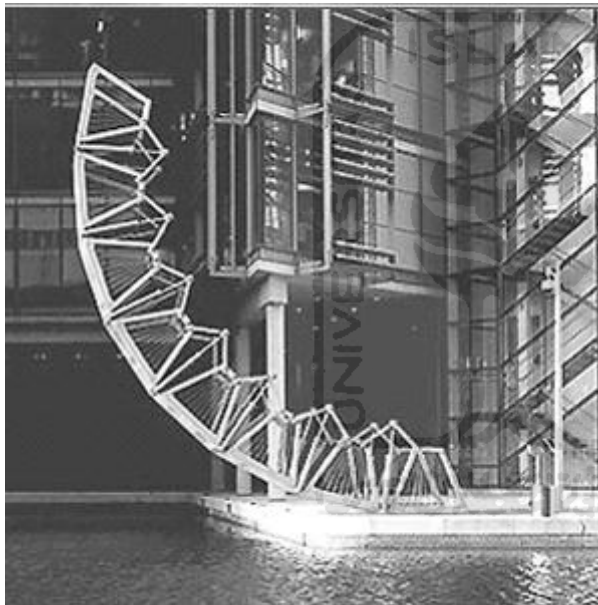
Gambar 2.4 jembatan yang bergerak ke atas ketika ada kapal yang lewat merupakan kinetik arsitektur sederhana
