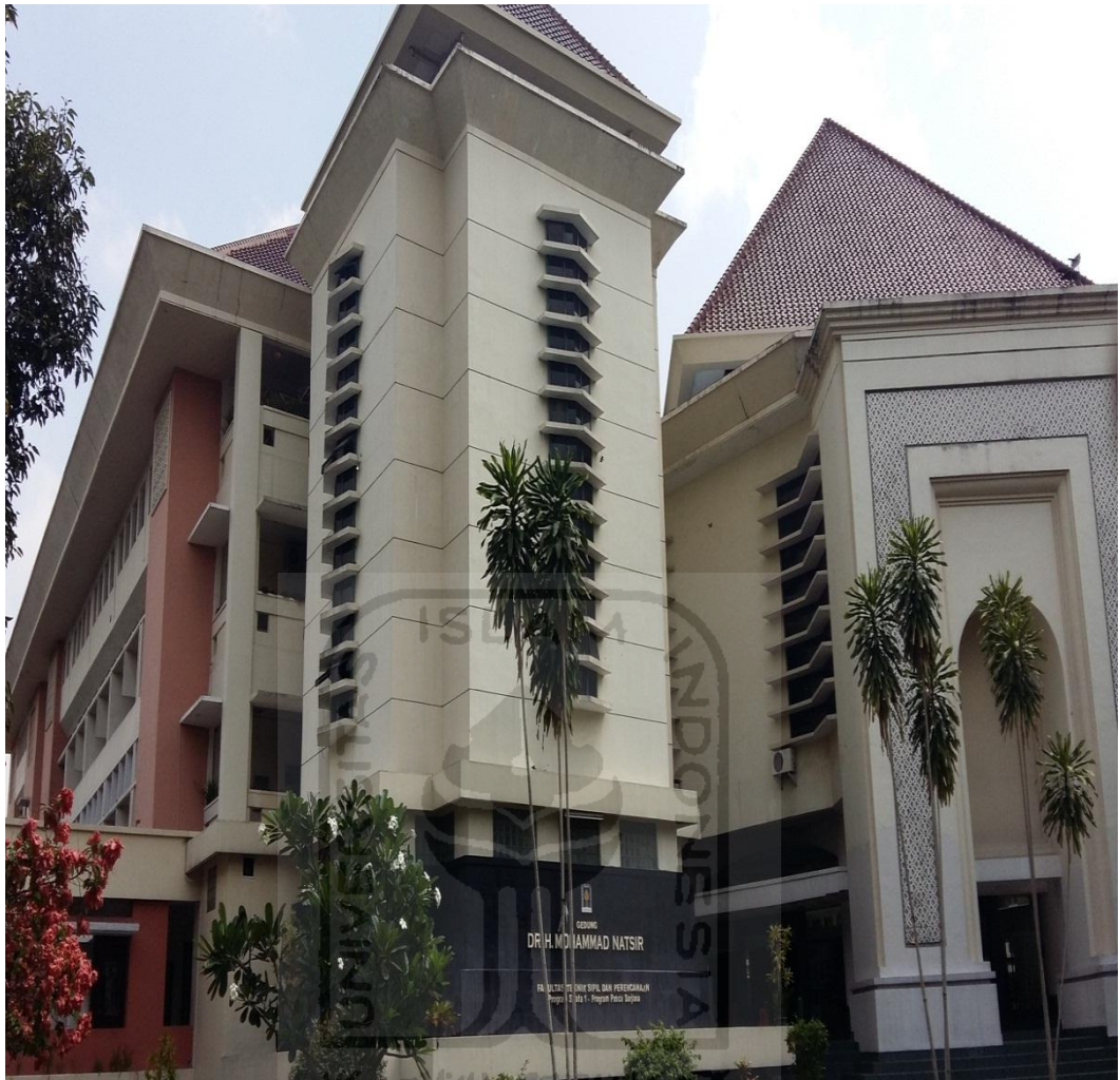
Gambar 4.4 Gedung Fakultas Teknik Sipil
