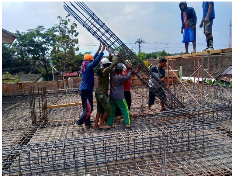
Gambar L-1.1 Pemasangan tulangan kolom
