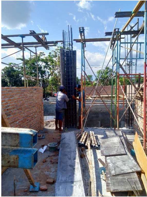
Gambar L-1.5 Pemasangan bekisting kolom
