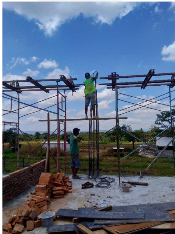
Gambar L-1.4 Pemasangan tulangan sengkang kolom
