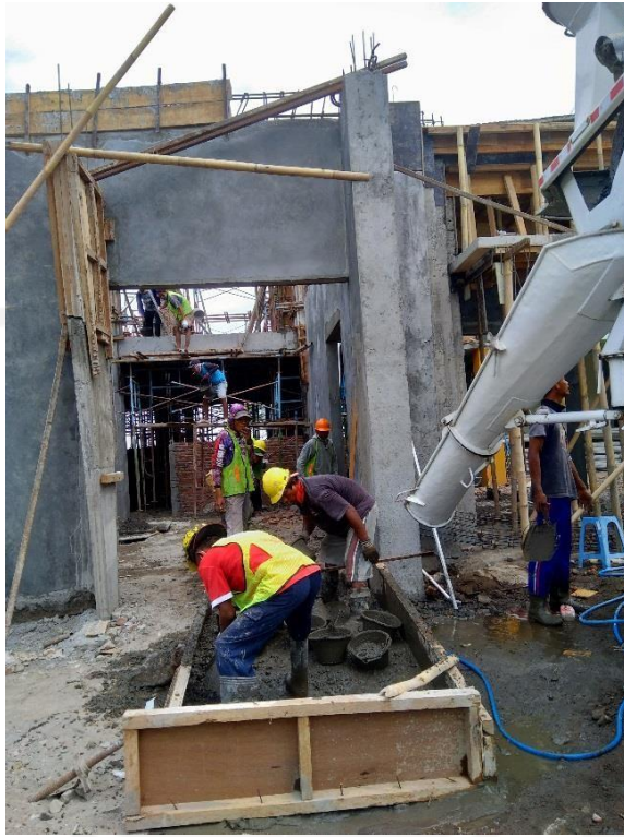
Gambar L-1.7 Pengangkutan adukan beton
