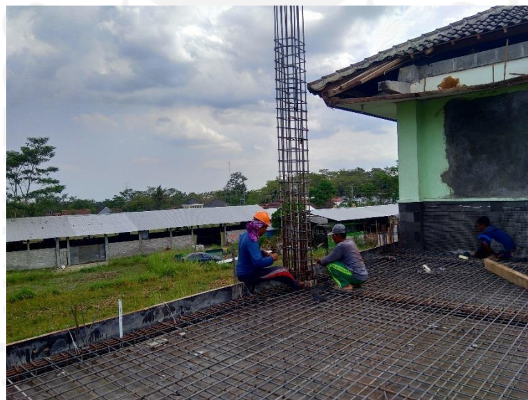
Gambar L-1.2 Tulangan kolom setelah dipasang
