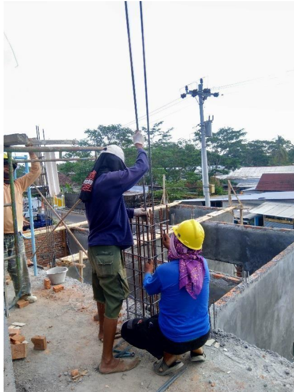
Gambar L-1.3 Pemasangan tulangan pokok kolom
