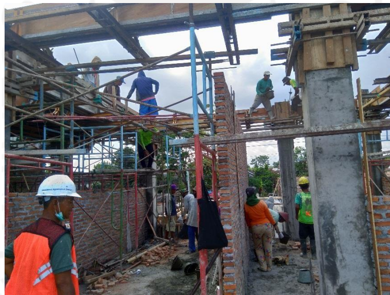
Gambar L-1.10 Pengecoran kolom
