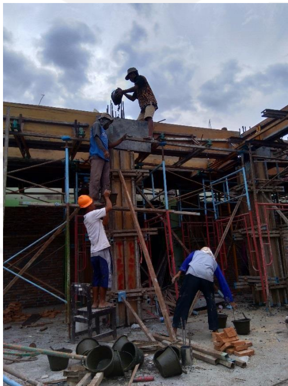
Gambar L-1.8 Pengecoran kolom
