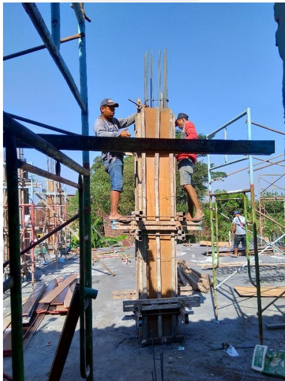
Gambar L-1.6 Pemasangan bekisting kolom
