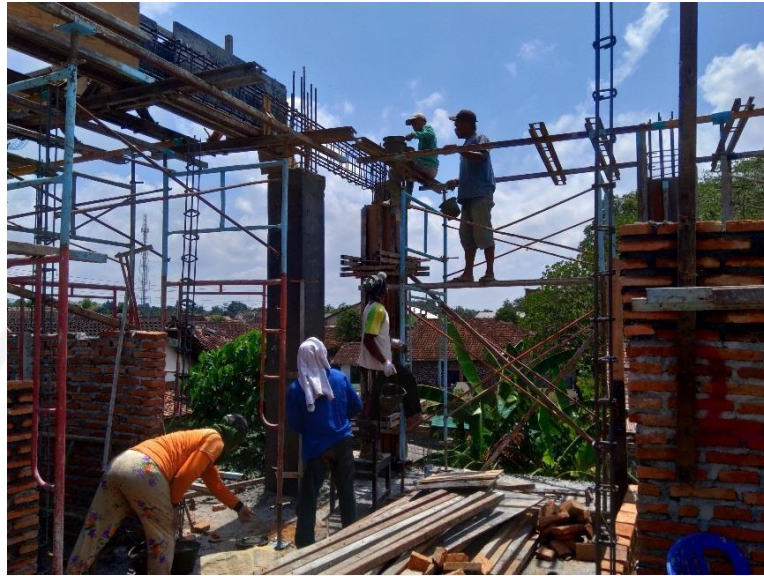
Gambar L-1.9 Pengecoran kolom
