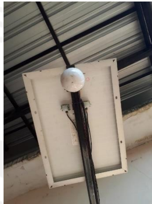
Gambar 4.1 Penempatan Sensor PIR
