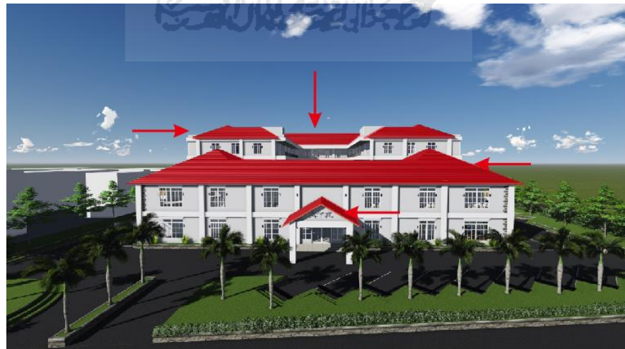
Gambar 3.29 Bentuk Atap Perisai dan Pelana Dengan Penutup Atap Genteng
