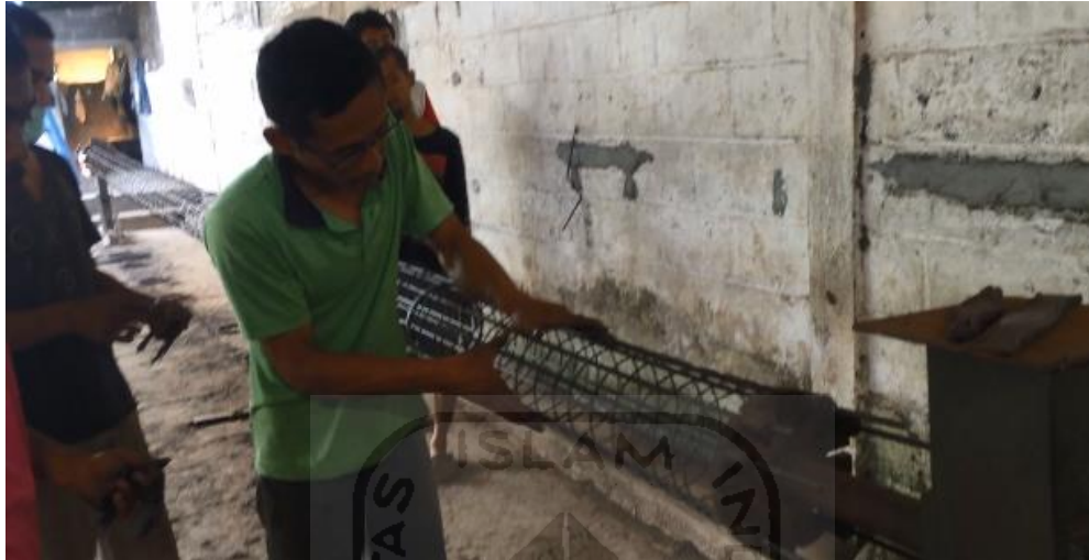
Gambar 4.25. Kondisi awal kerja dilapangan
