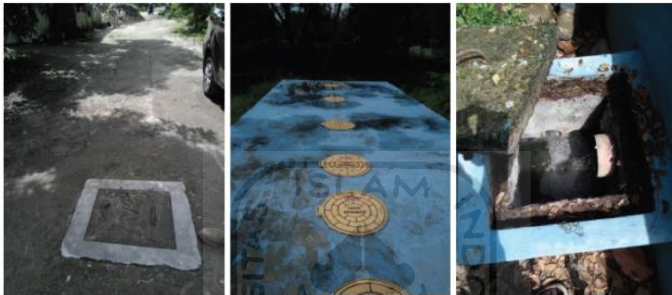
Gambar 2.3. Kondisi IPAL Blendangan Desa Tegaltirto Sumber : Olah data primer,2016
