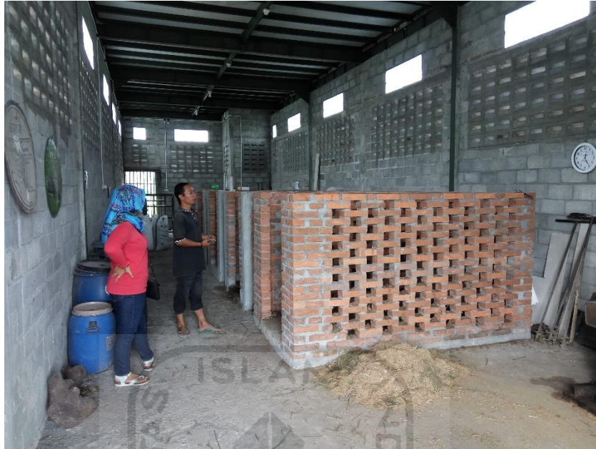
Gambar 4.8 Bangunan 3R Lantai 1 TPS 3R Gemah Ripah (Sumber : Dokumen pribadi, 2016)
