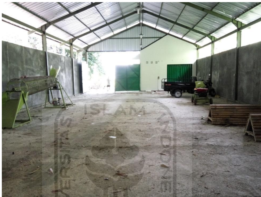
Gambar 4.6 Lokasi Bangunan 3R TPS 3R Kauman Bersatu (Sumber : Dokumen pribadi, 2016)
