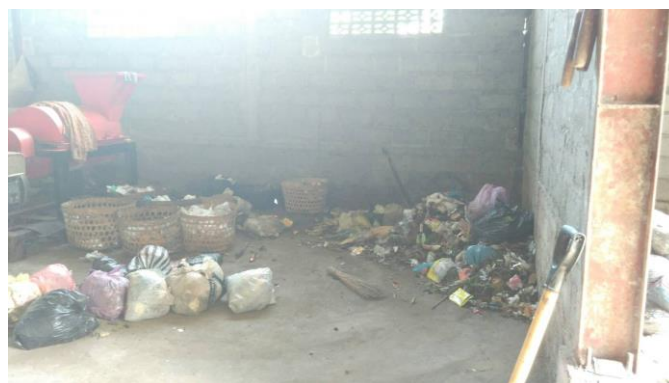
Gambar 4.4 Kondisi Area Pemilahan TPS 3R Atras (sumber: dokumentasi pribadi, 2016)
