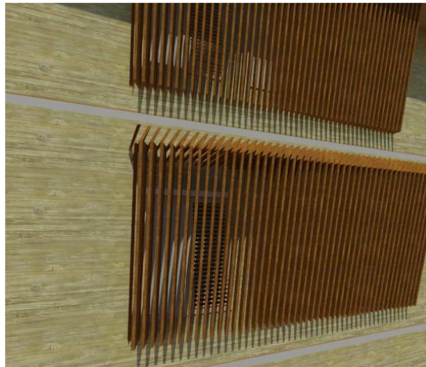
Gambar 4.24. Kisi-kisi bukaan yang menghadap langsung ke cahaya matahari (Sumber: analisis penulis, 2016)
