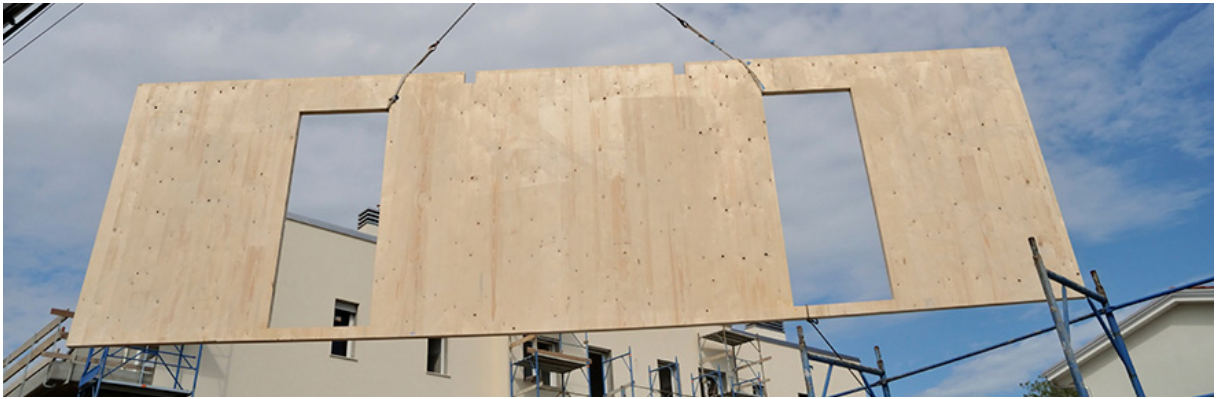
Gambar 3.4. Konstruksi dengan panel pabrikasi
