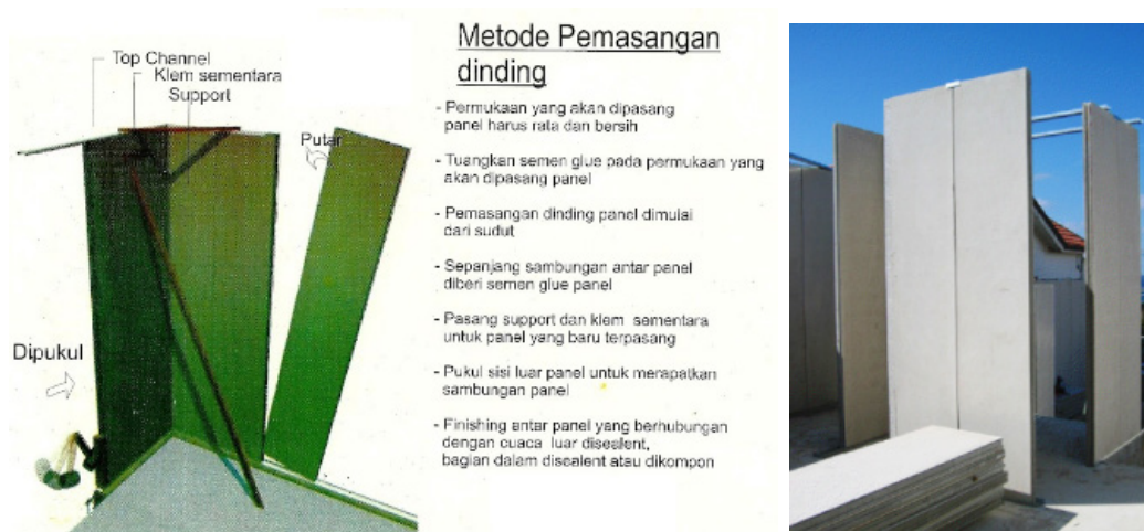
Gambar 3.12 Qui Panel dinding beton ringan
