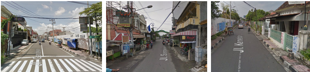
Gambar 2.2 Kondisi Jalan Sekitar Site
