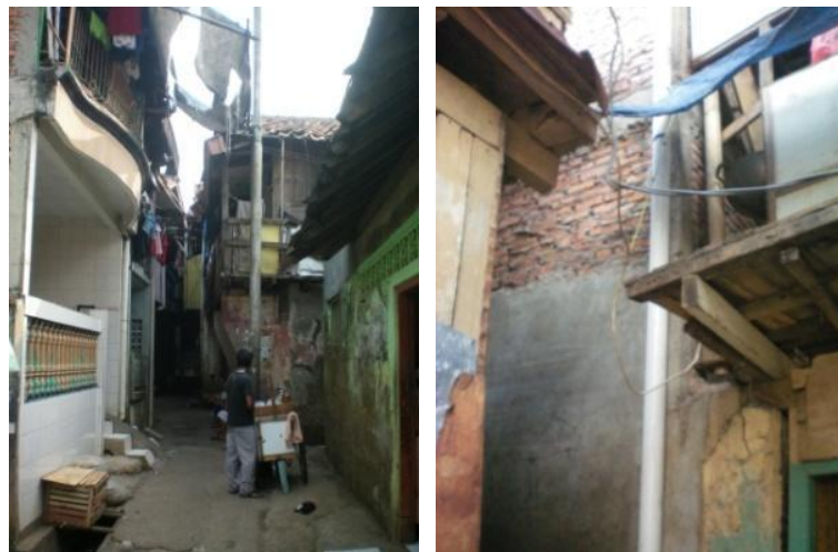
Gambar 2.6 Kondisi Bangunan di Kampung Pulo
