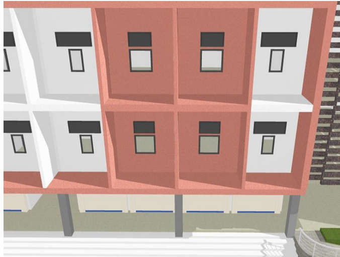
Brise-soliel pada fasad bangunan rumah susun
