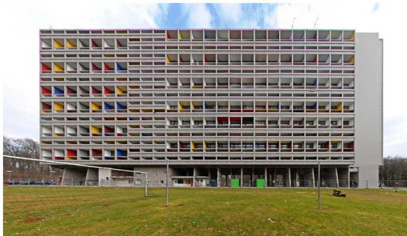
Bagian depan bangunan
