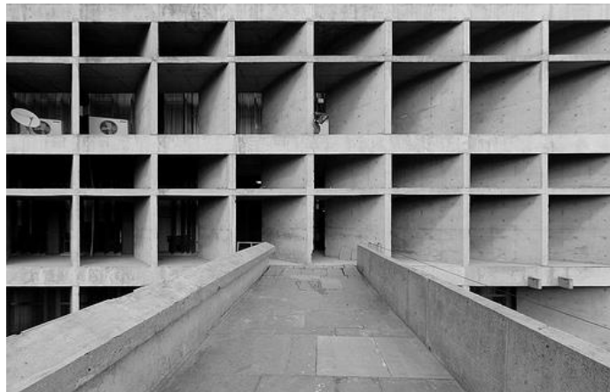
Brise-soleil pada fasad Gedung DPR, Chandigarh
