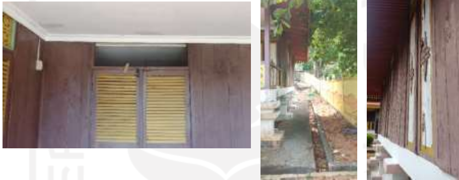
Gambar II. 23 : Tampak dan Kondisi Bangunan Penyokong (B-4)
