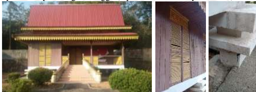
Gambar II. 22 : Tampak dan Kondisi Bangunan Penyokong (B-3)
