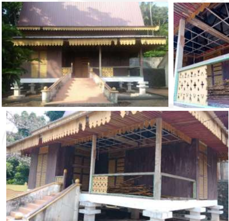
Gambar II. 20 : Tampak dan Kondisi Bangunan Penyokong (B-1)
