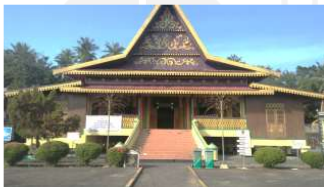
Gambar II. 17 : Tampak Depan Bangunan Induk Balai Adat Indera Perkasa
