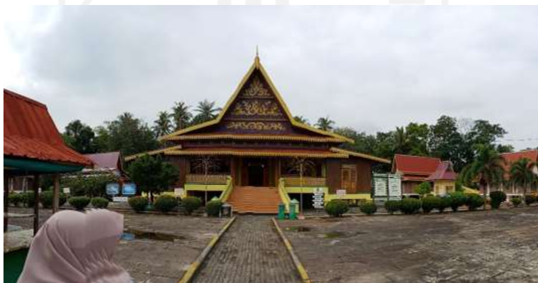
Gambar II. 16 : Keadaan Eksisting Komplek Balai Adat Indera Perkasa
