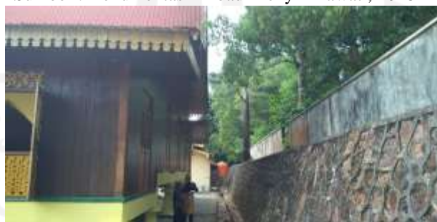
Gambar II. 18 : Tampak Belakang Bangunan Induk Balai Adat Indera Perkasa
