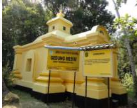
Gambar II. 34 : Gudang Mesiu Pulau Penyengat
