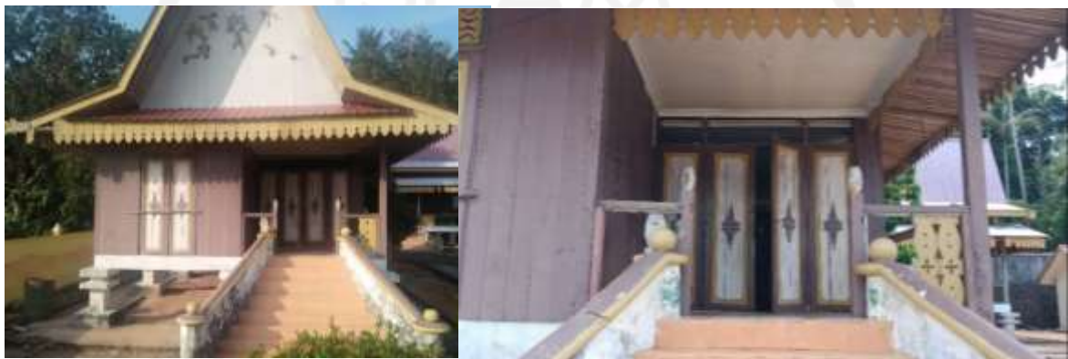
Gambar II. 21 : Tampak dan Kondisi Bangunan Penyokong (B-2)
