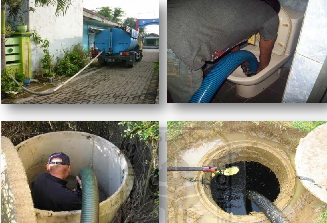
Gambar.2.4. Kegiatan penyedotan Lumpur tinja
