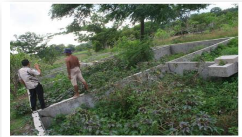
Gambar.2.13. IPLT yang tidak difungsikan (IUWASH & WSP 2014)
