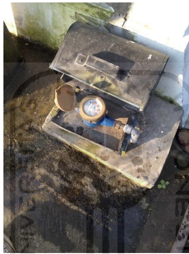
Gambar 4.18. Meteran air yang ada di selatan Musholla
