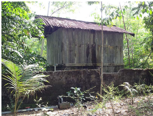
Gambar 4.6. Bangunan bak pengumpul utama Padakuan Kalimantan
