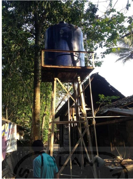
Gambar 4.16. Tangki air yang berada di atas sumur
