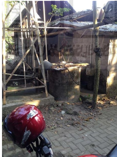
Gambar 4.15. Bangunan sumur Padukuhan Jelapan
