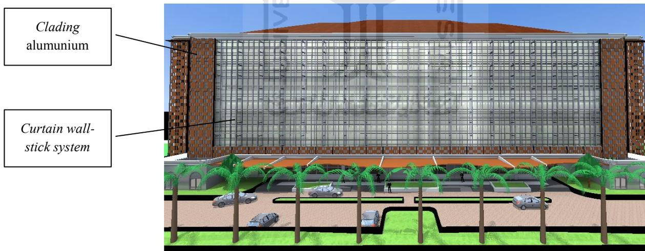
Gambar 144. *Clading* alumunium pada fasad Timur.
