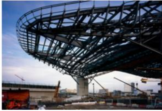
Gambar 10 Sistem Struktur London Aquatic Centre (Sumber: HIMAARTRA)
